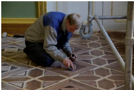
Рисунок 3. Заполнение углублений специальной пастой
