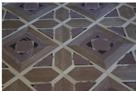
Рисунок 4. Фрагмент паркета после затирки углублений пастой
