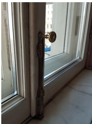
Рисунок 10. Нижний шпингалет там же
