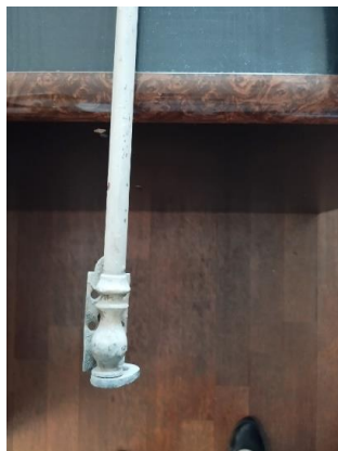
Рисунок 13. Состояние длинного шпингалета (кремона) до реставрации
