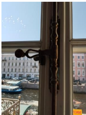
Рисунок 2. Длинный шпингалет Большого зала Строгановского дворца, деталь.
