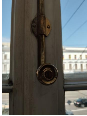
Рисунок 11. Деталь верхнего шпингалета
