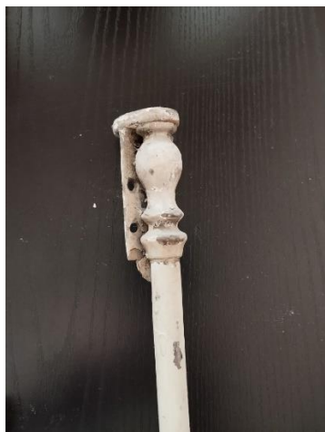
Рисунок 12. Состояние длинного шпингалета (кремоны) до реставрации
