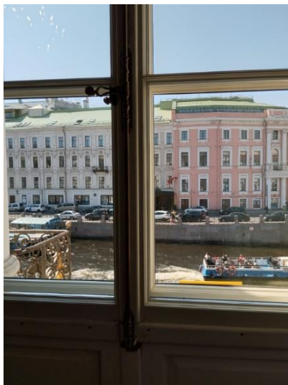
Рисунок 1. Длинный шпингалет Большого зала Строгановского дворца;
