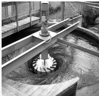
Рисунок 19. Вихревая водяная электростанция, автор проекта и строитель Franz Zotloterer
