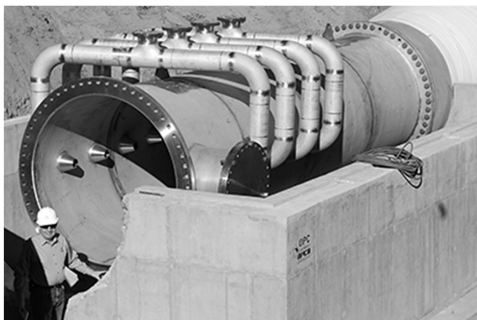
Рисунок 11. Конструкция системы аэрации потока сточной воды озоном или кислородом воздуха
