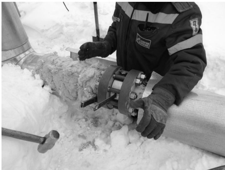
Рисунок 2. Монтаж межфланцевого узла контроля скорости коррозии
