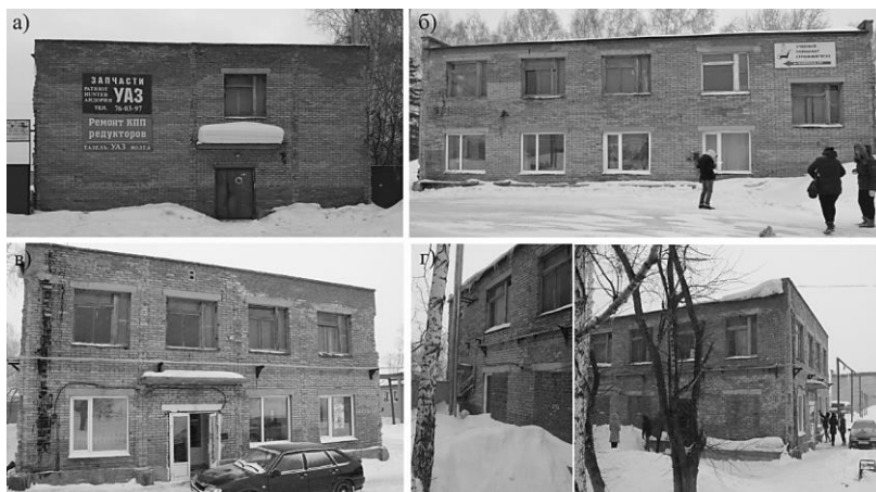
Рисунок 1. Фотофиксация обследуемого здания: а) северо-восточный фасад; б) юго-восточный фасад; в) юго-западный фасад; г) северо-западный фасад
