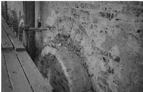
Рисунок 2. Фасад по Невскому проспекту. Срубленный сандриик. Окно второго этажа
