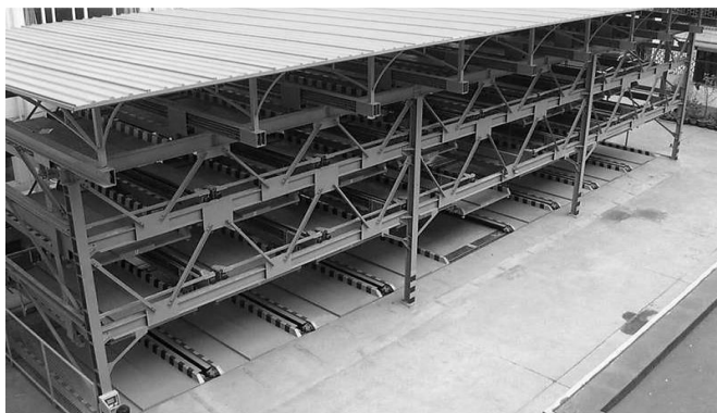
Рисунок 1. Пример многоуровневой сборной парковки из металлоконструкций
