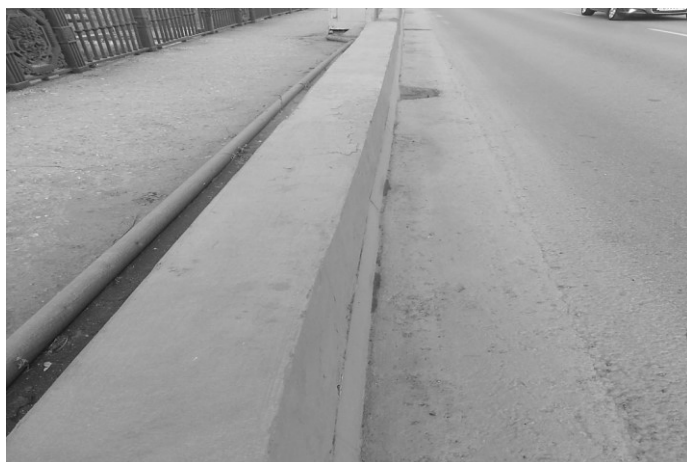
Рисунок 6. Отремонтированное цементобетонное ограждение на Коммунальном мосту г. Новосибирска (вид со стороны проезжей части)
