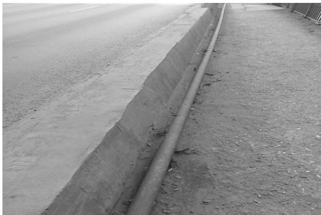
Рисунок 5. Отремонтированное цементобетонное ограждение на Коммунальном мосту г. Новосибирска (вид со стороны тротуара)
