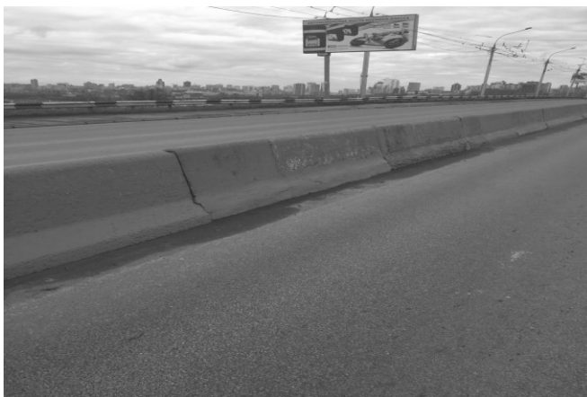
Рисунок 2. Дорожное парапетное ограждение типа «Нью-Джерси» на Коммунальном мосту г. Новосибирска
