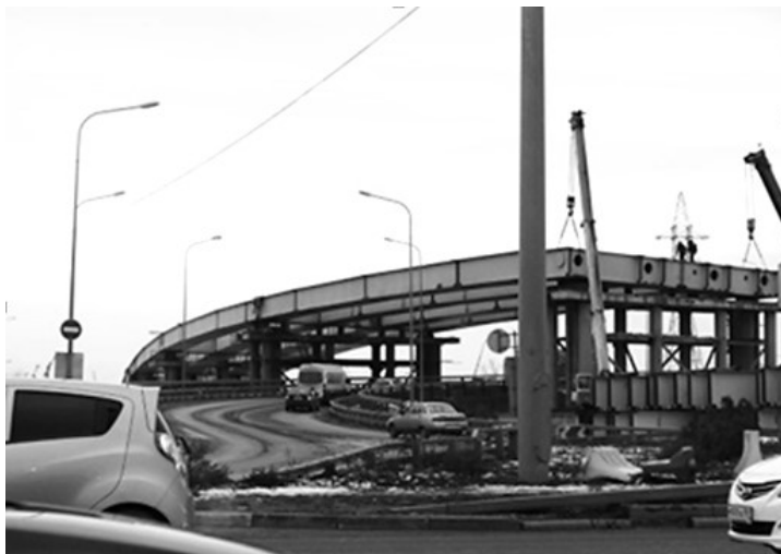
Рисунок 3. Работы по сборке конструкции эстакады
