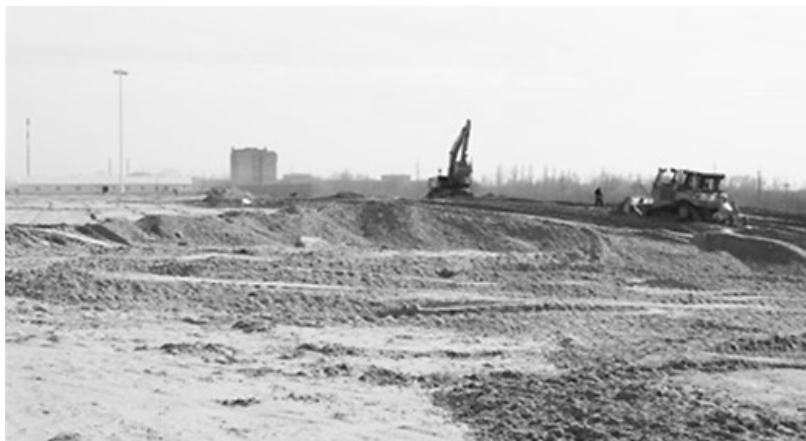
Рисунок 2. Устройство насыпи земляного полотна
