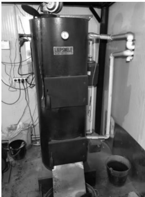
**Рисунок 2. Котел длительного горения Liepsnele, установленный в СОНТ «Чочур Мыран»**
