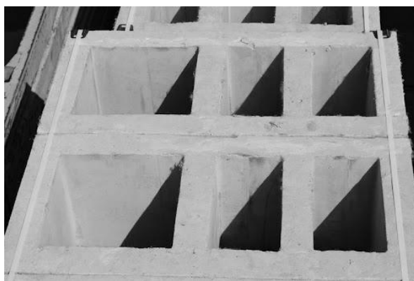
Рисунок 5. Вентиляционный канал из блоков фибропенобетона
