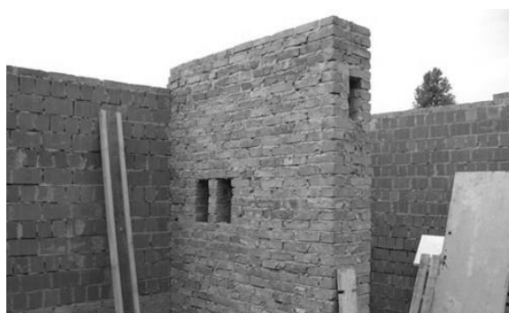
Рисунок 1. Вентиляционный канал из кирпича
