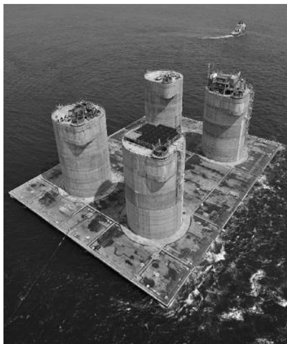
Рисунок 2. Бетонный ледозащитный пояс платформы «Беркут»
