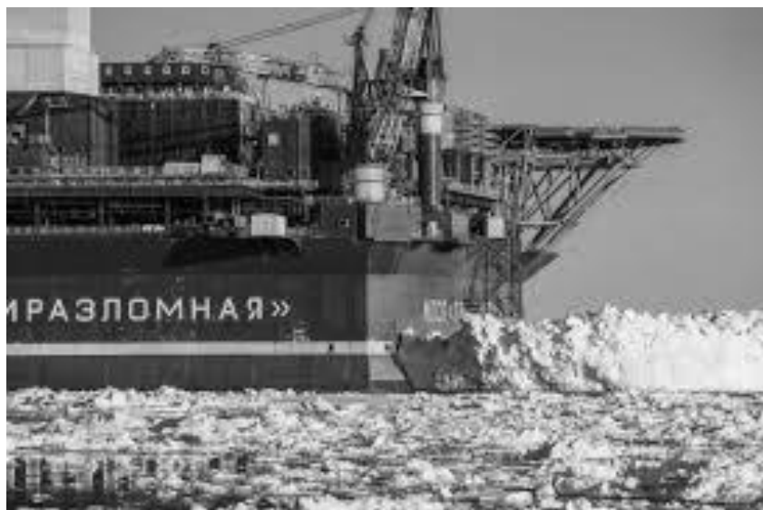
Рисунок 1. Ледовый дефлектор платформы «Приразломная»
