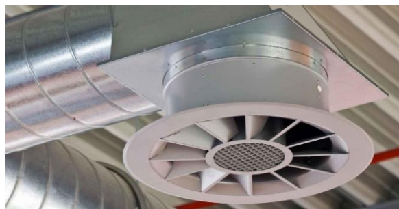
Рисунок 1. Система дымоудаления с подпором воздуха
