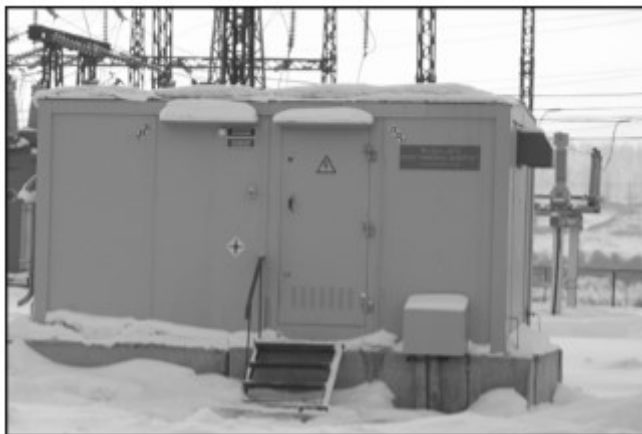
Рисунок 6. Модульный блок ДГА
