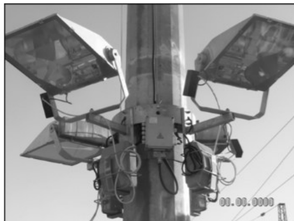
Рисунок 4. Станционное освещение ВОУ-30
