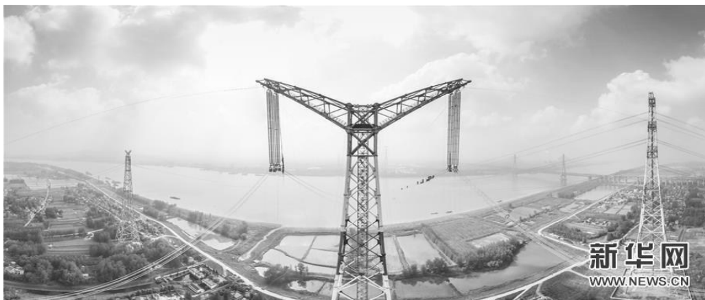
Рисунок 6. Линия электропередачи с напряжением 1100 киловольт в Китае
