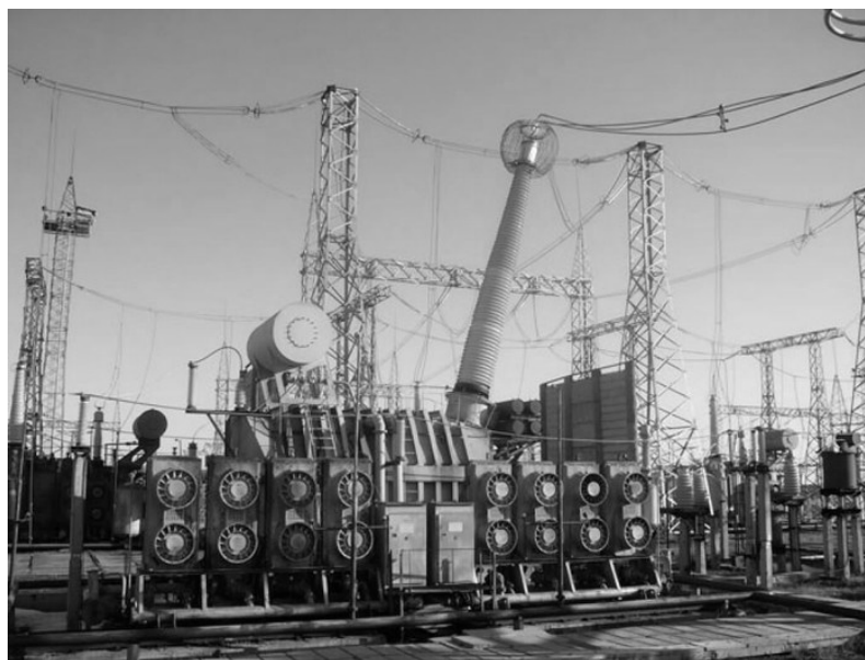
Рисунок 5. Трансформатор 1150 кВ
