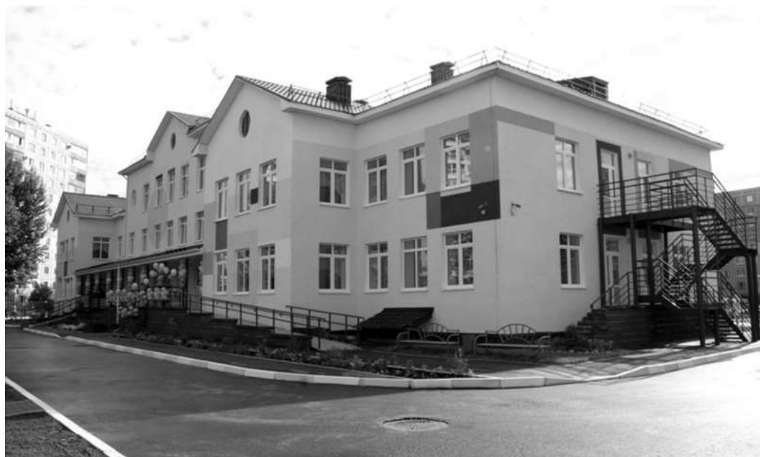
Рисунок 1 Детский сад №78 г. Уфа. На фотографии видны эвакуационные выходы со 2 и 1 этажей
