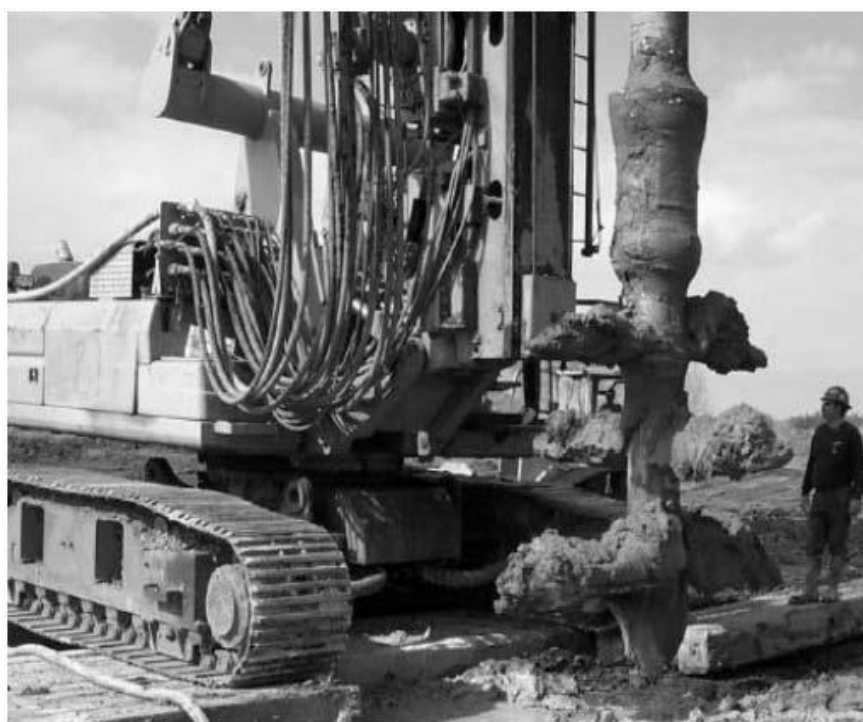
Рисунок 2. Рабочий инструмент для бурсмесительной технологии перемешивания грунта
