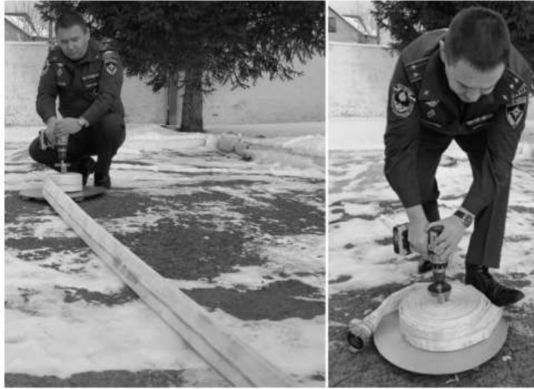
Рисунок 2. Процесс формирования скатки напорного рукава опытным образцом технического решения
