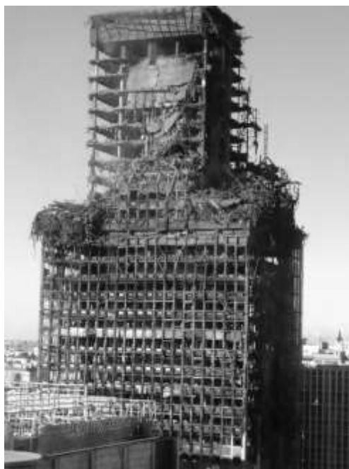
Рисунок 4. Последствия пожара в небоскребе “Виндзор” в Мадриде (Италия)
