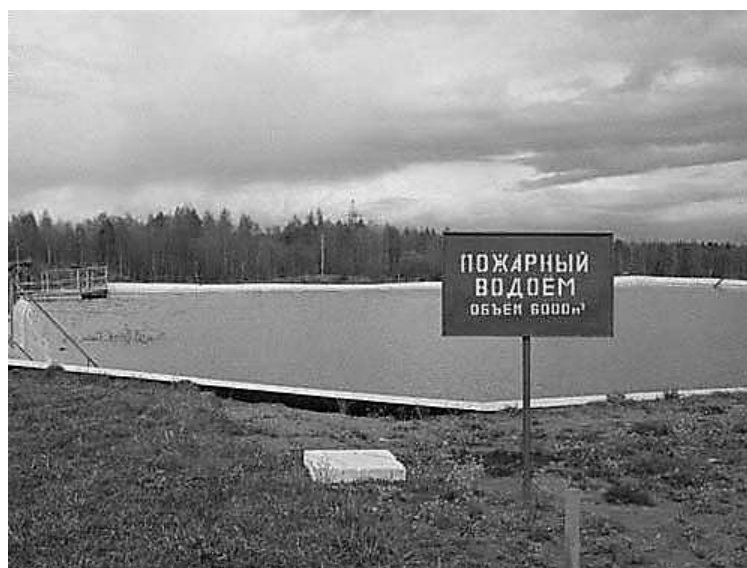
Рисунок 1. Искусственный пожарный водоём
