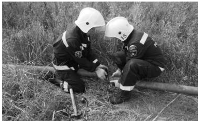
Рисунок 2. Прокладка магистральной линии для обводнения торфяников
