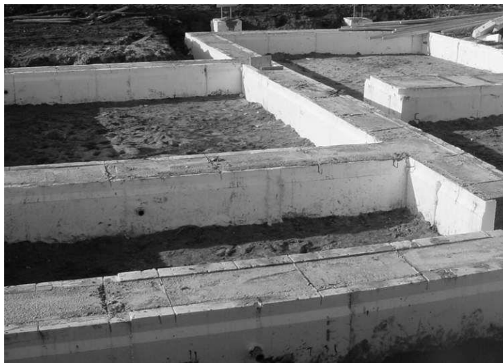
Рисунок 2. Сборный ленточный фундамент
