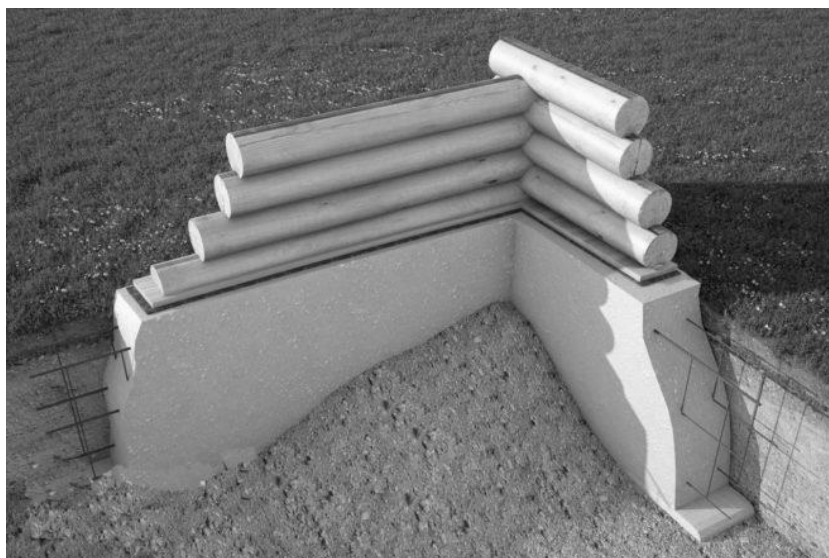
Рисунок 1. Монолитный ленточный фундамент
