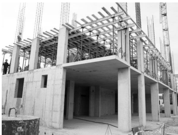
Рисунок 1. Пример монолитного строительства
