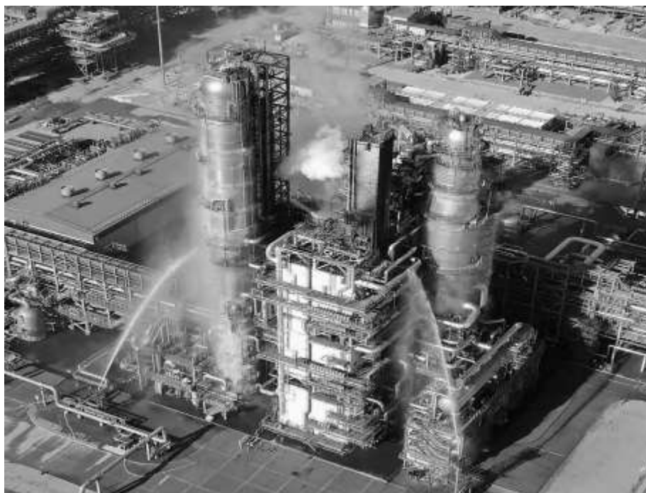
Рисунок 1. Амурский газоперерабатывающий завод, последствия пожара в следствии разгерметизации установки
