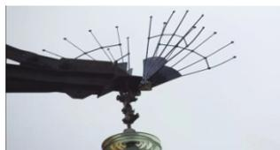
***Рисунок 3. Устройства антиприсадочного типа ЗП-АП.***
