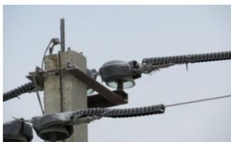
***Рисунок 1. ПЗУ из полимерных материалов и защитный кожух на провод.***
