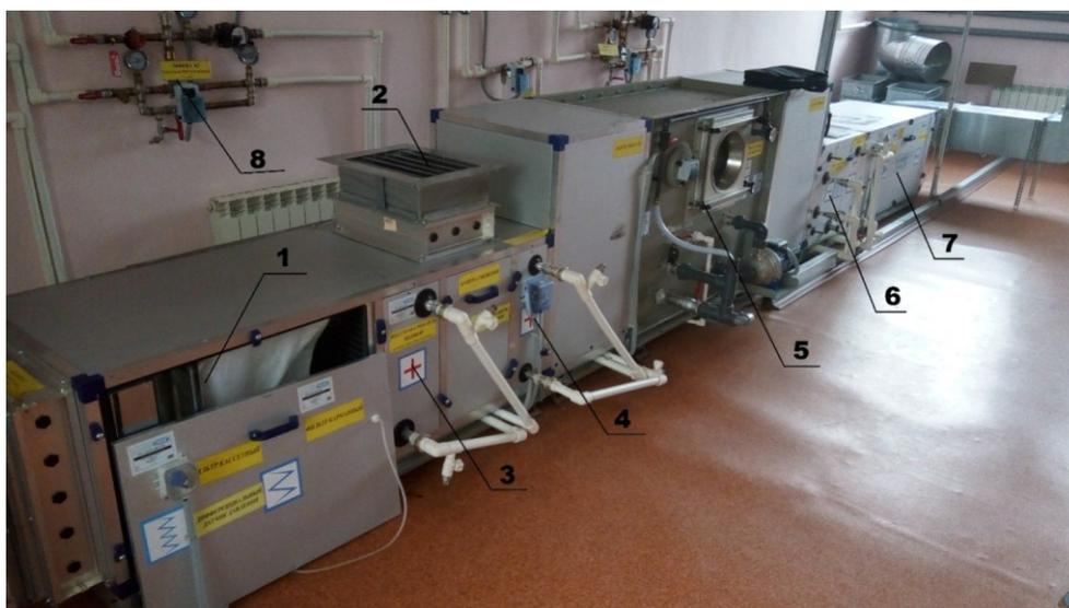
**Рисунок 1. Приточная установка: 1 – секция кассетного и карманного фильтров; 2 – клапан рециркуляции воздуха; 3 – теплообменник рекуператора; 4 – водяной калорифер; 5 – камера орошения; 6 – водяной воздухоохладитель; 7 – секция вентилятора и шумоглушителя. 8 – узел регулирования для водяного калорифера**
