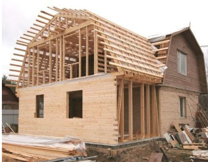
Рисунок 3. Каркасная пристройка к дому
