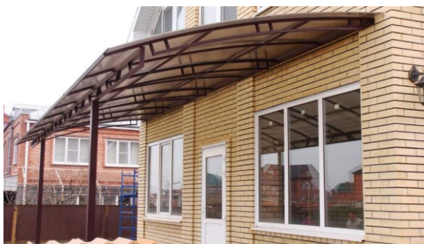
Рисунок 2. Пример пристройки к дому – навес
