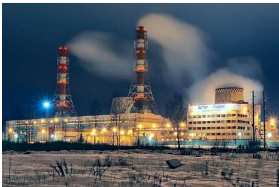
Рисунок 1. Северо-Западная ТЭЦ, г. Санкт-Петербург
