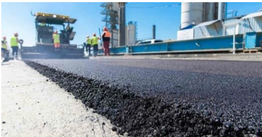
Рисунок 1. Асфальтовое покрытие с добавлением резиновой крошки
