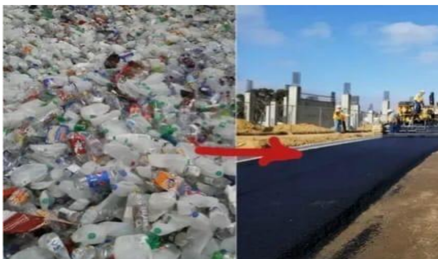
Рисунок 2. Асфальтовое покрытие с добавлением полимера из переработанного пластика в асфальтовой смеси
