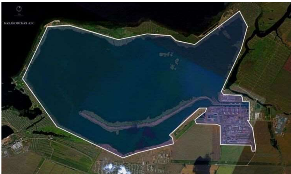
Рисунок 1. Зона безопасности вокруг Балаковской АЭС
