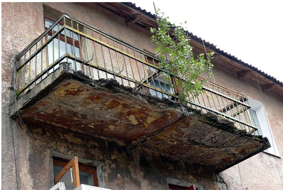
***Рисунок 1. Обрушение балконной плиты***
