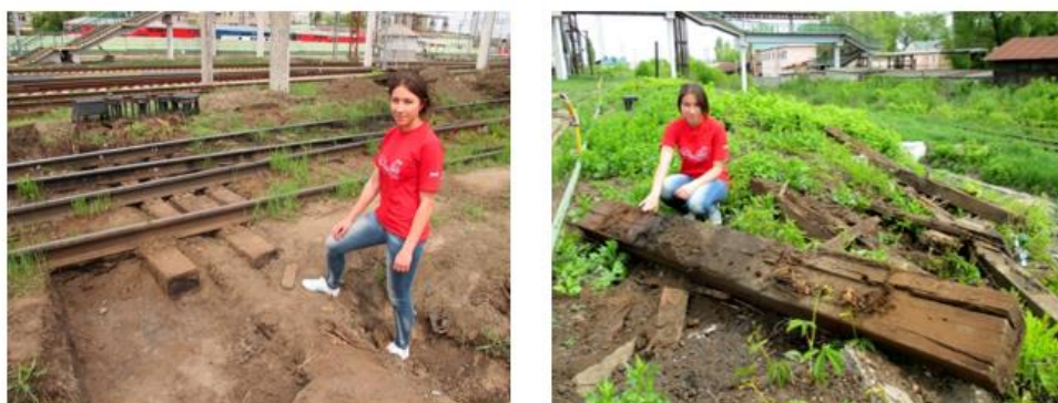
Рисунок 1. Кустовая гнилость шпал
