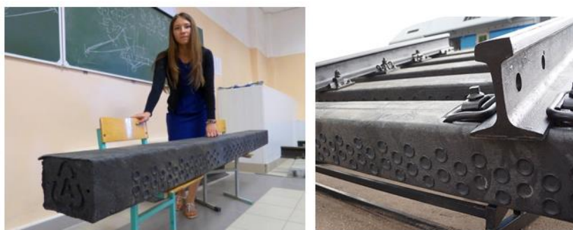
Рисунок 5. Пластиковая шпала и рельсошпальная решётка на пластике
