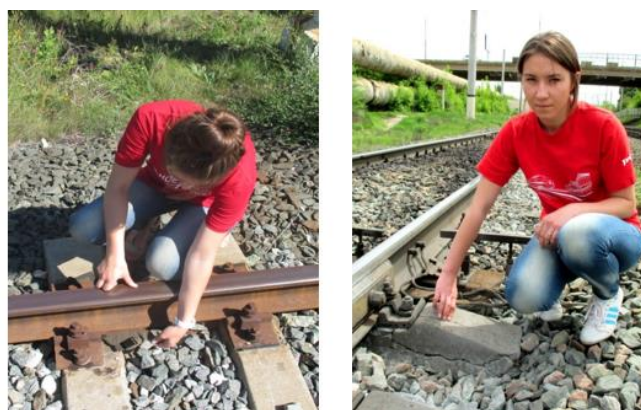
Рисунок 3. Износ амортизирующего вкладыша и лопнувшая шпала
