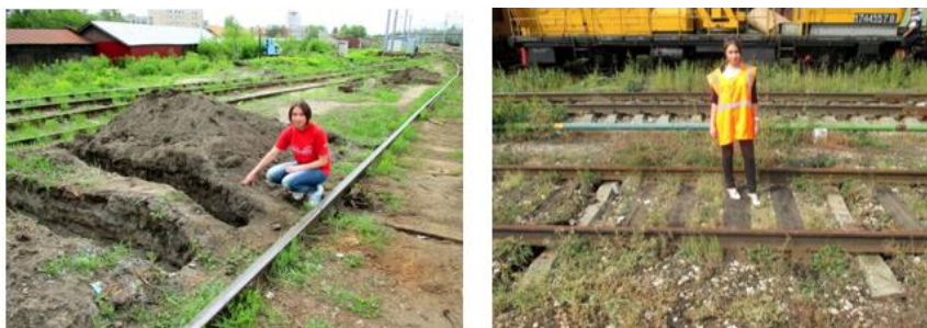
Рисунок 2. Установка в деревянный путь железобетонных шпал
