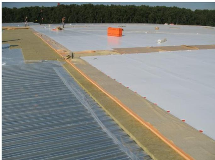
*Рисунок 2. Однослойное покрытие на примере устройства мембранной кровли по основанию из профилированного листа*
