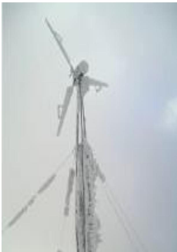
*Рисунок 1. Состояние ветроустановки после снежной бури*
