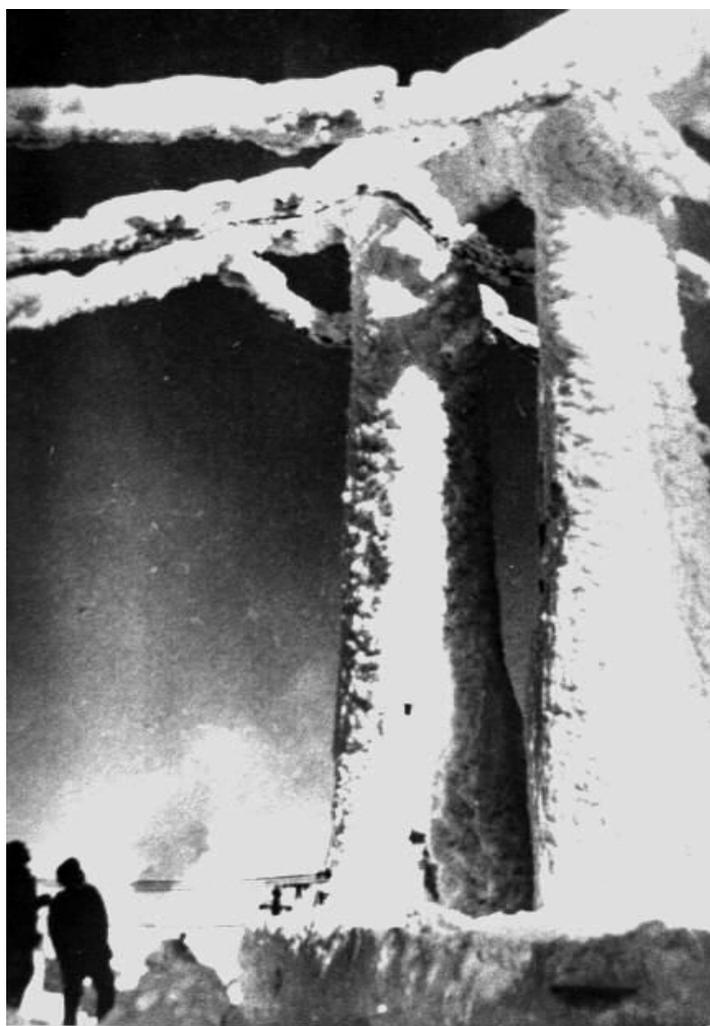
*Рисунок 1. Состояние линии электропередачи после снежной бури в Павлодарской области*
