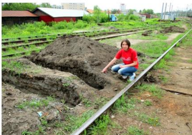
Рисунок 4. Подготовительные работы к замене деревянных шпал
