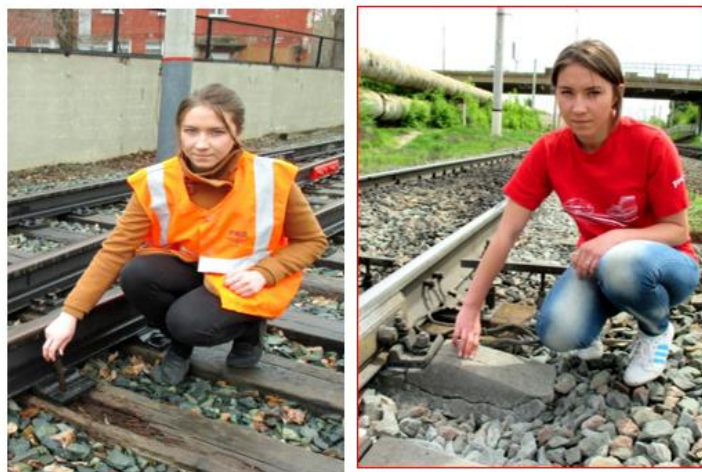
Рисунок 3. Прогнившая деревянная и лопнувшая железобетонная шпала
