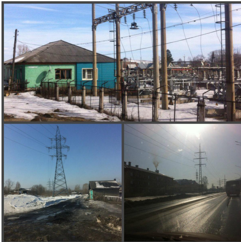
Рисунок 1. Близкое расположение ЛЭП к жилым помещениям
