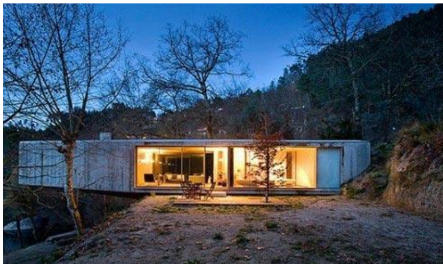
Рисунок 3. Жилой дом в национальном парке в Португалии. Архитекторы Граса Коррейя и Роберто Равацци
