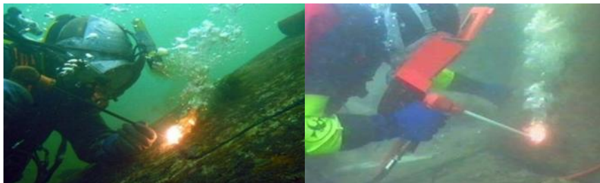
Рисунок 2. Мокрая сварка
