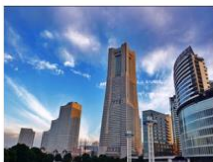
Рисунок 3. Yokohama Landmark Tower («Башня-ориентир», Иокогама, Япония)
