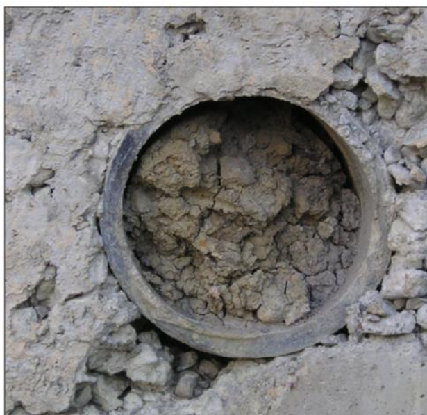
Рисунок 1. Дренажное окно, забитое глинистым материалом
