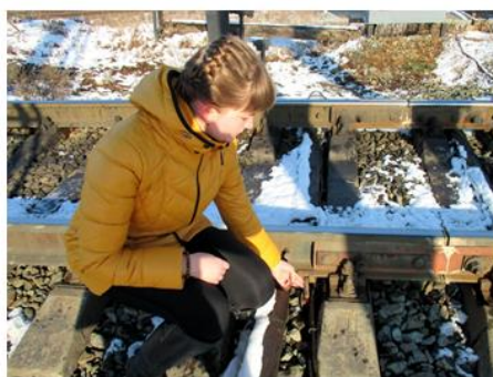
Рисунок 4. Держатели электротяговых соединителей (перемычек)
