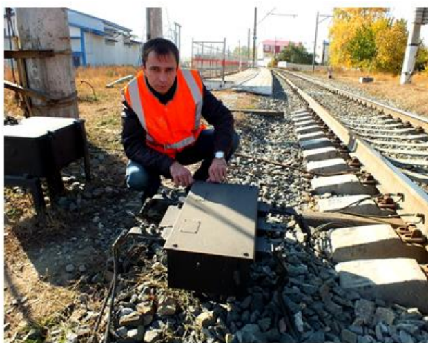
Рисунок 2. Дроссель-трансформатор новой формы 2ДТ-1МГ
