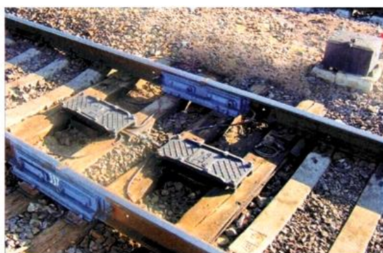
Рисунок 5. Дроссель-трансформатор в шпальном исполнении
