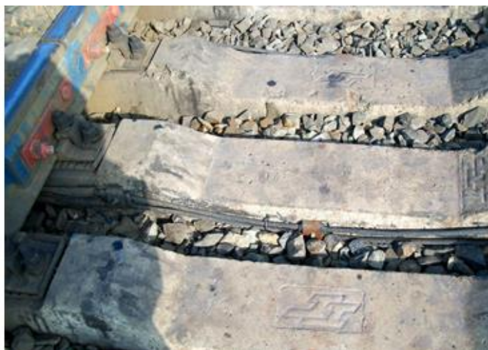
Рисунок 7. Крепление перемычек к бетонной шпале дюбелями
