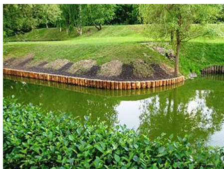
Рисунок 6. Устройство берегоукрепительных сооружений
