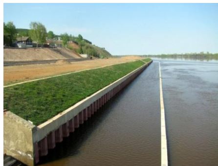
Рисунок 6. Устройство берегоукрепительных сооружений
