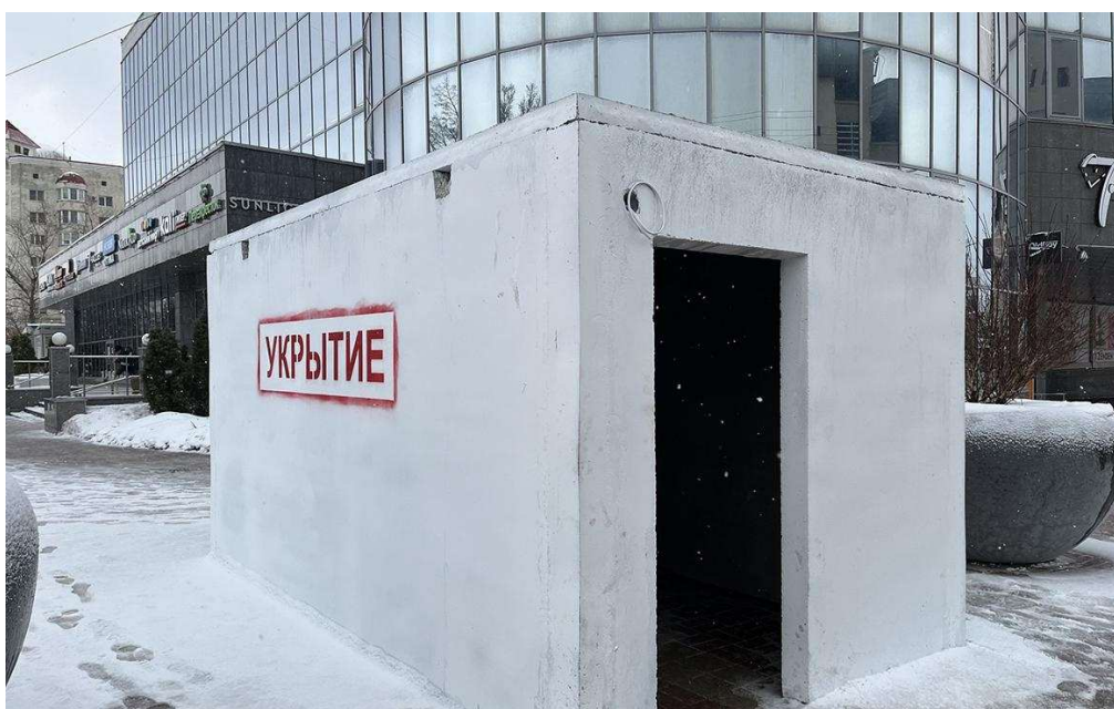
Рисунок 3. Модульное защитное сооружение в Белгородской области
