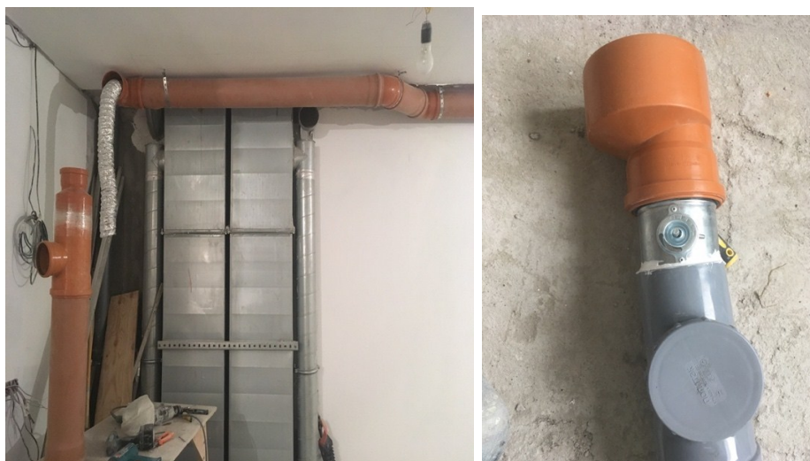
Рисунок 2. Реализованный коаксиальный рекуператор
