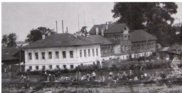
Рисунок 1. Ул. Набережная VI Армии, д. 81. Историческое фото
