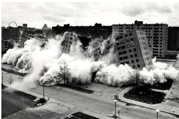
Рисунок 2. Снос домов комплекса
